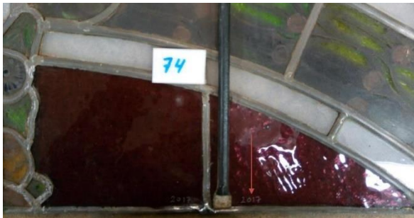
Fig. 40. Sustitución de vidrio coloreado con marca de año de intervención. Discernible.
