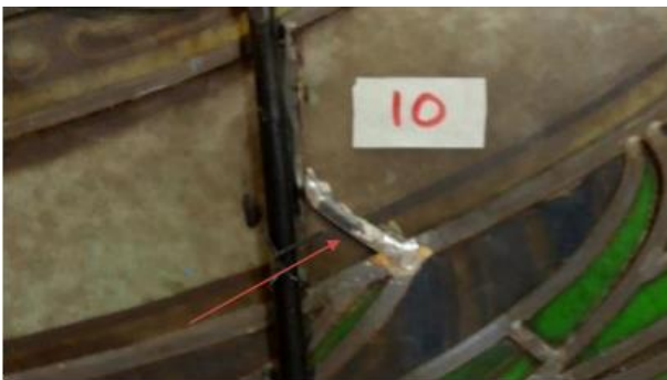
Fig. 3. Detalle de la colocación de ala de plomo. Intervención anterior
