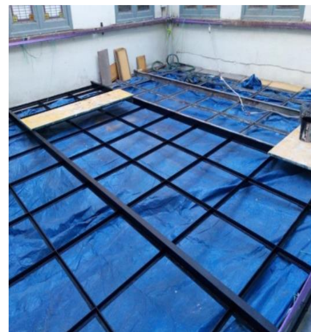
Fig. 26. Estructura sustentante en proceso de intervención.
