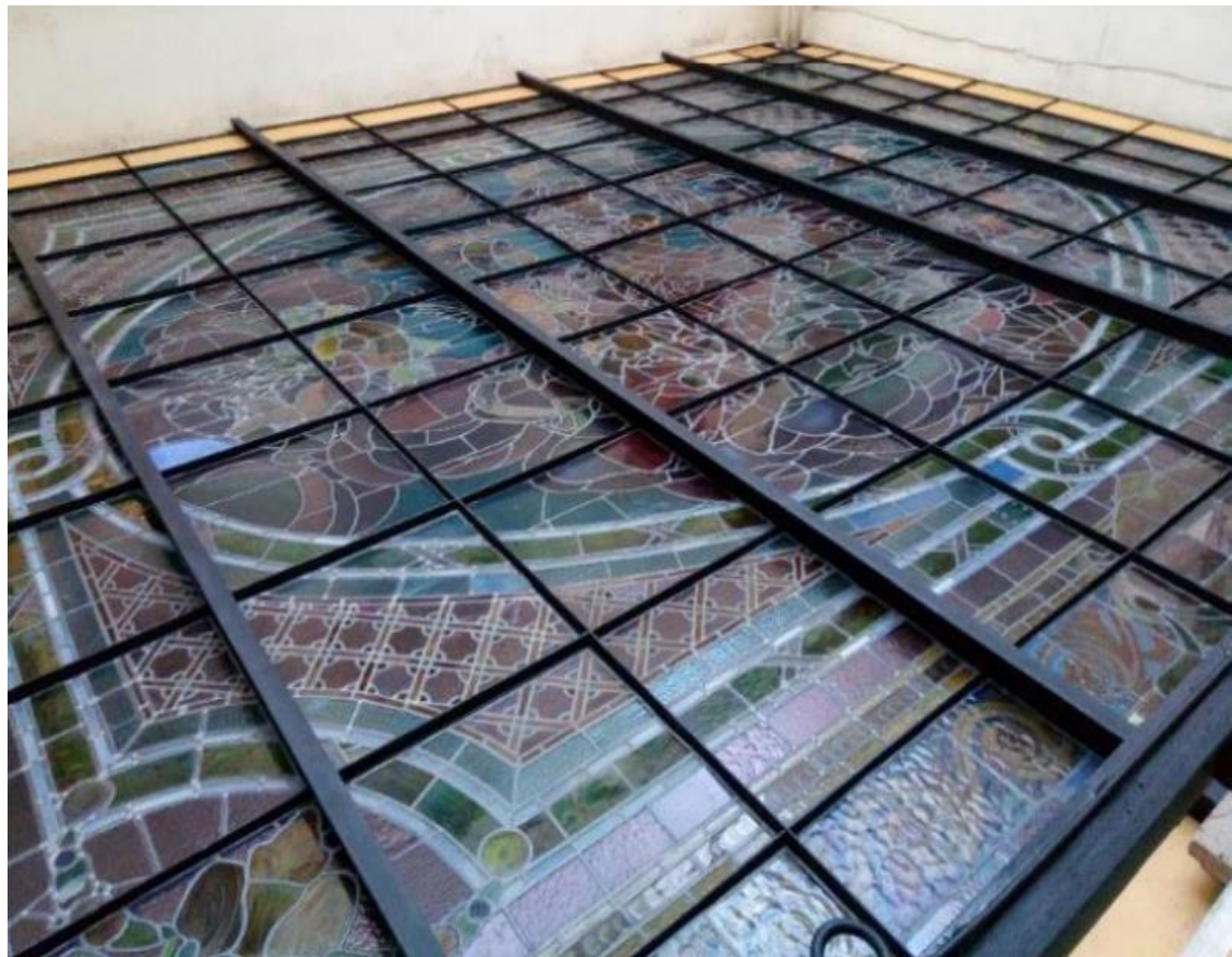
Fig. 41. Reverso. Vista general tras la actual intervención.
