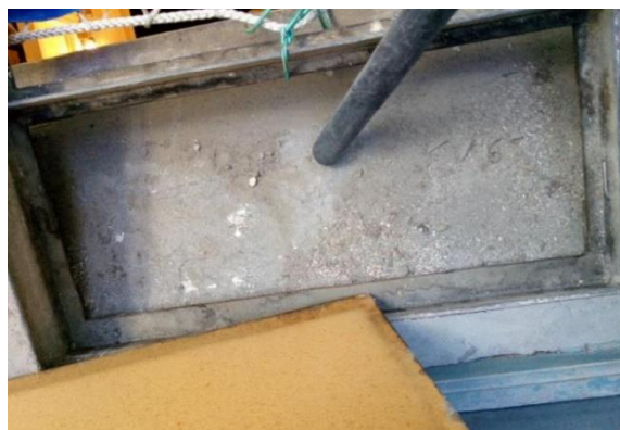
Fig. 36. Proceso de limpieza de la cornisa superior.
