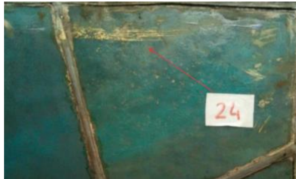
Fig. 8. Resto de pintura de la cornisa en el anverso de la vidriera. Panel 24
